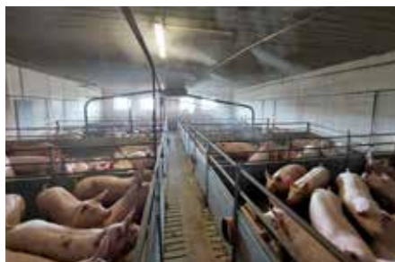
► Der feine Sprühnebel kühlt die Luft um ca. 5 °C ab
