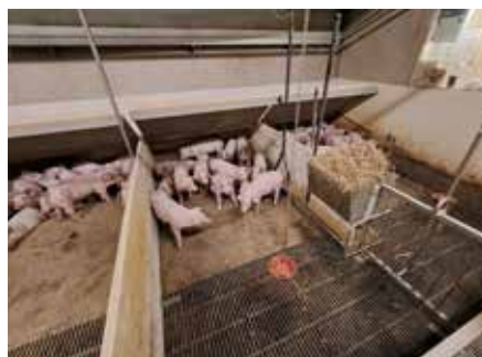
► Ferkelaufzucht mit Strohraufe, befestigter Fläche und 3-Kant-Rosten
