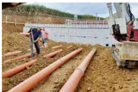
► Verlegung des Erdwärmetauschers
