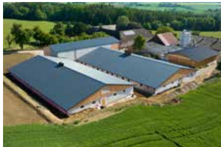
► Der neu gebaute Zuchtsauenstall
